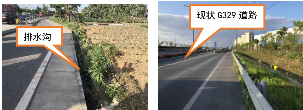
图 2.3-4 现状 G329 国道防护工程、排水工程现状照片
